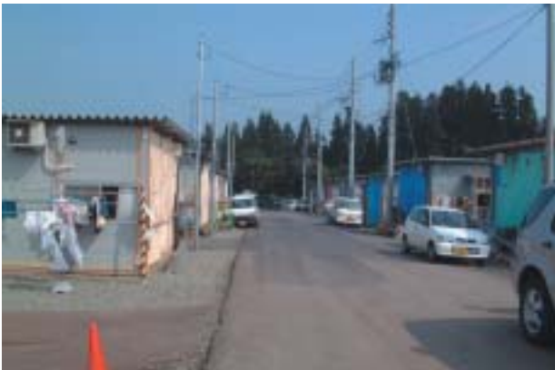
長岡市に設置された応急仮設住宅
