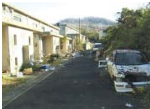
村営住宅の荒廃状況（阿古地区）
