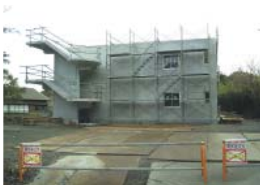
村営住宅新設工事（神着団地）
