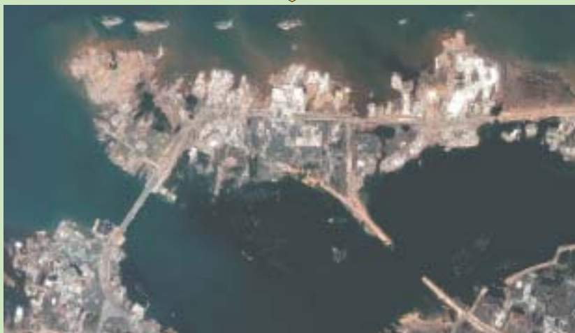
津波到達後（平成16年12月28日撮影）
