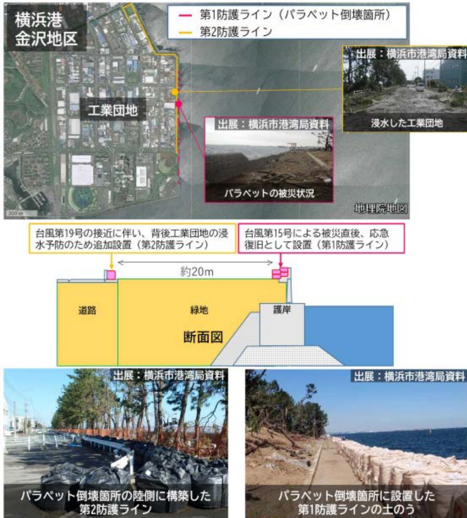
図 横浜港での土のう設置状況
