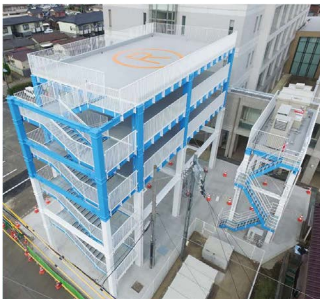
図 境町水害避難タワー
