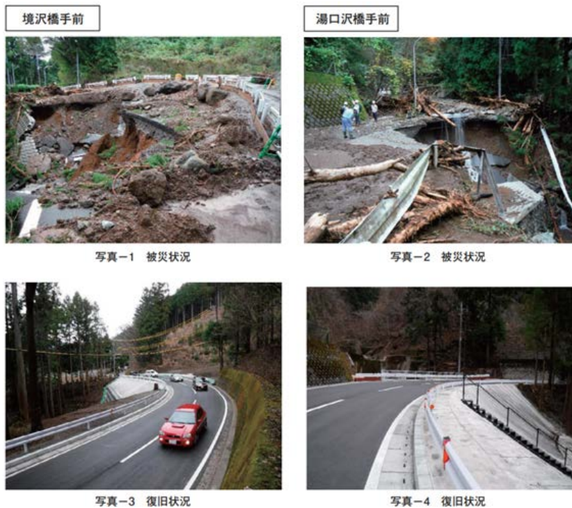
図 被災状況と復旧状況
