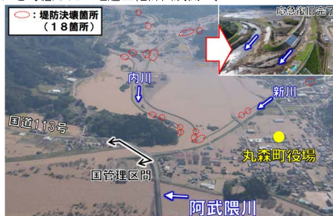
図 被災状況と復旧状況（宮城県）
