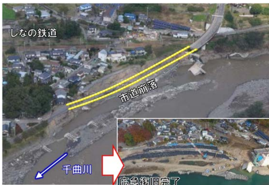
図 被災状況と復旧状況
