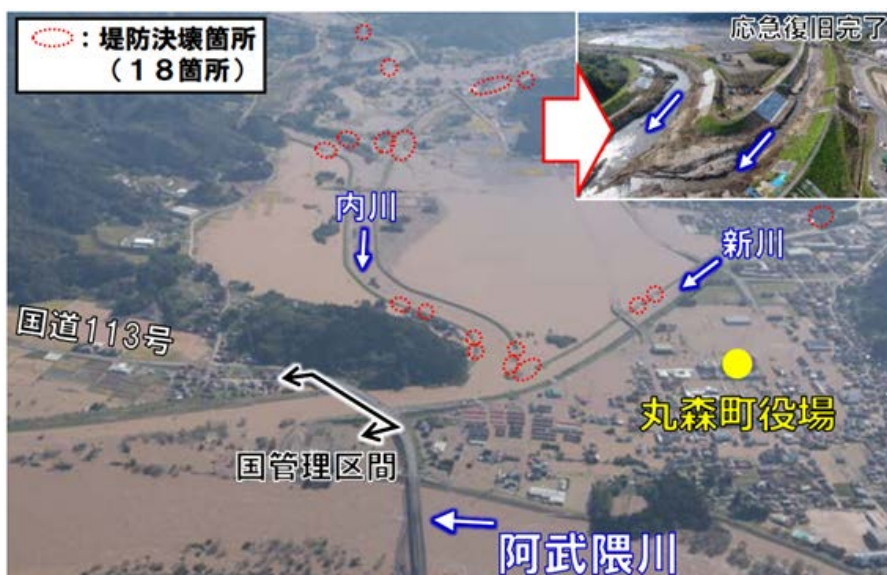
図 被災状況と復旧状況（宮城県）
