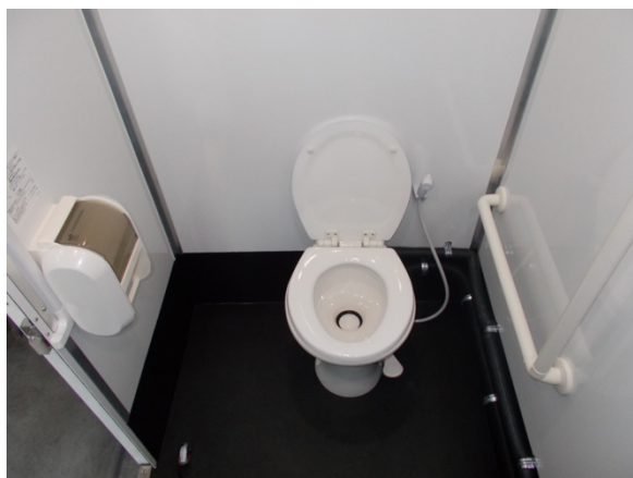
(図：災害用トイレトレーラー内部)
