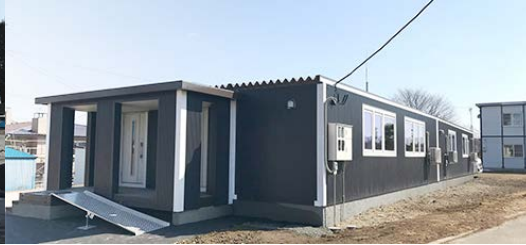
厚真町京町地区仮施設設
