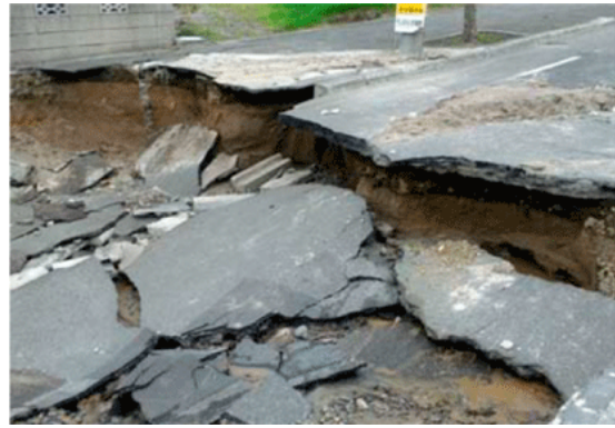
地盤沈下により道路が陥没（清田区平岡地区）
