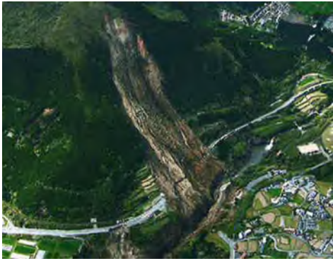
斜面崩壊による道路寸断と落橋 (国道 57 号・国道 325 号 阿蘇大橋付近)
