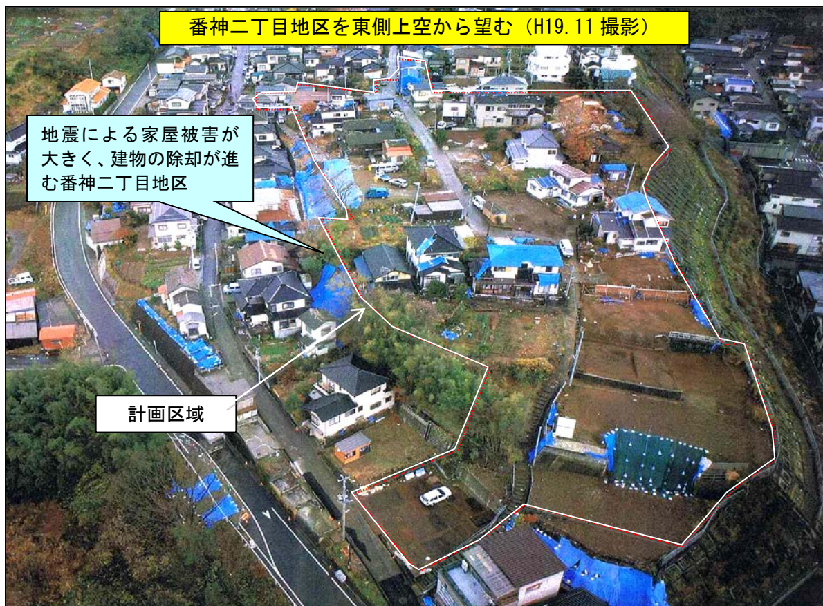
写真 番神二丁目地区を東側上空から望む (H19.11撮影)
