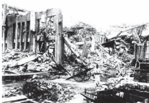
内外ビル (建設工事中に崩壊)
