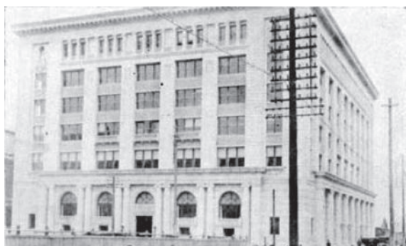
日本興業銀行 (1923年竣工、 内藤多仲による耐震壁を取り入れた設計)
