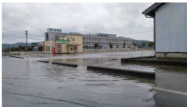
佐賀県武雄市の六角川氾濫の被害（内閣府資料）
