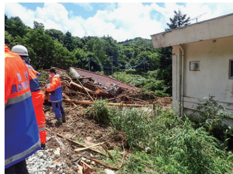
長崎県雲仙市の土砂崩れの被害（内閣府資料）
