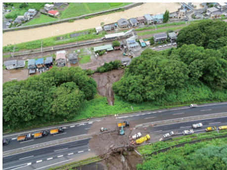
長野県岡谷市の土砂崩れの被害（内閣府資料）
