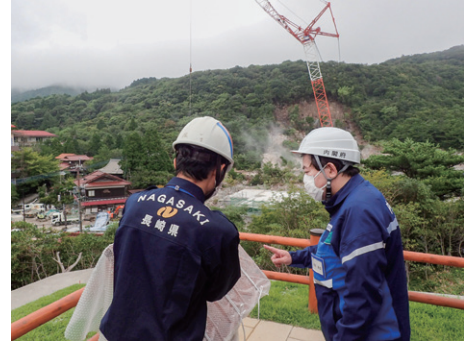
長崎県の被災現場を視察する 棚橋内閣府特命担当大臣（防災）（当時）（内閣府資料）
