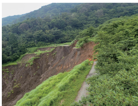
静岡県熱海市における土石流の源頭部 (内閣府資料)
