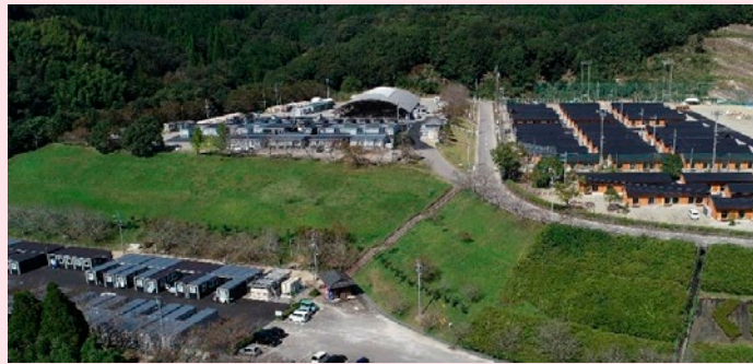
球磨村で整備された応急仮設住宅（左手前・奥がムービングハウス、右が木造仮設住宅）
