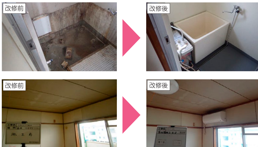
用途廃止した市営住宅の改修（熊本県人吉市）
