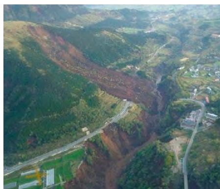
阿蘇大橋地区における斜面崩壊の様子
