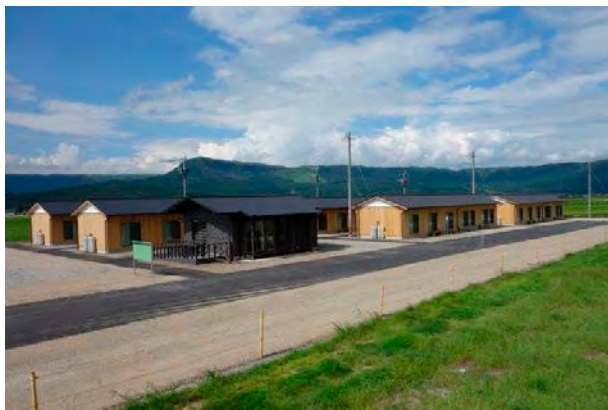
建設型仮設住宅の一例 (木造型)
