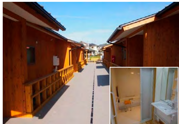
建設型仮設住宅の一例 (車いすに対応したバリアフリー型)
