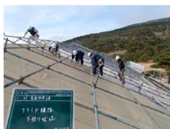
図4 アラミド繊維による補強改修工事の例 (環境省：えびのエコミュージアムセンター)
