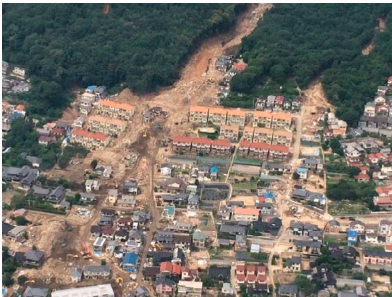
広島市で発生した土砂災害等の様子
