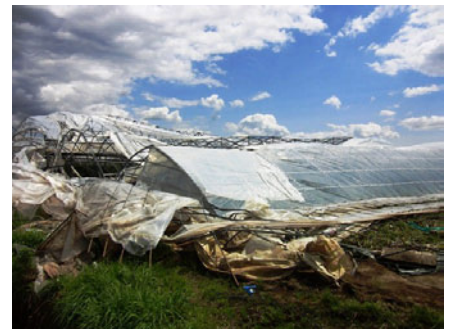
竜巻により破損したビニールハウス
