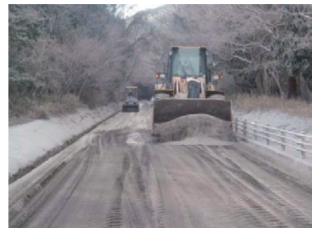
道路の降灰除去作業
