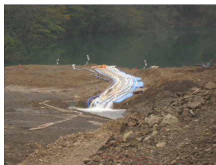
河道閉塞の決壊を防止するための緊急排水作業
