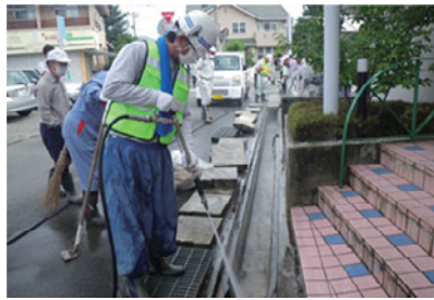
側溝の汚泥の除去
