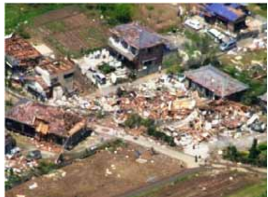
竜巻による被害状況（茨城県）
