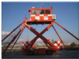
非常用管制塔外観
