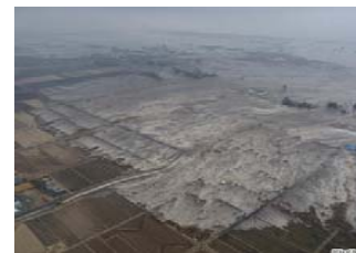
津波による海水の浸入 (東日本大震災 2011.3)
