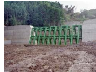
流木捕捉式治山ダム
