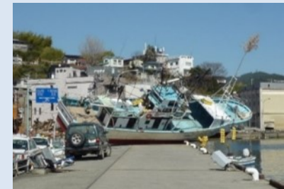
津波による被害（宮城県気仙沼市）
