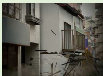
強い揺れによる建物崩壊
