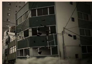
強い揺れによる建物崩壊
